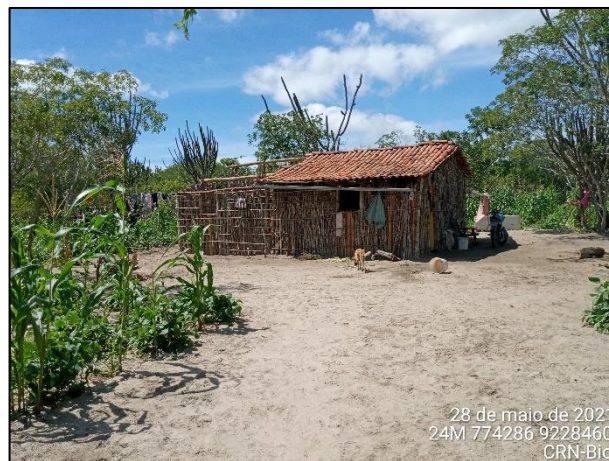
Figura 4.236: Residência de pau a pique localizada na AID do empreendimento, zona rural.
